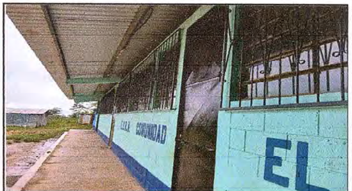
Foto 4: Mantenimiento de puertas y balcones y sustitución de vidrios de los tres módulos
