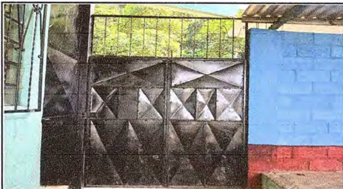
Foto 3: Colocación de portón
