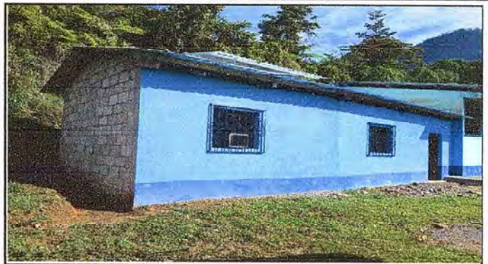
Foto 2: Ampliación de cocina y entechado, cambio de puerta y colocación de dos ventanas y dos balcones
