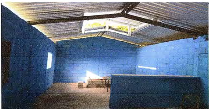
Foto 5: Colocación de piso rustico
